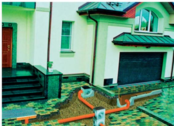
**Рисунок 6.** Дорожные покрытия из мелкоштучных элементов мощения на участках прокладки подземных коммуникаций.
