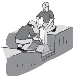
При установке необходимо соблюдать правильное размещение элементов и вертикальное положение. Каждый столбик нужно перемещать и выравнивать отдельно. При этом помогают деревянные колышки, которые сверху вставляются между столбиками и фиксируют их в вертикальном положении.
